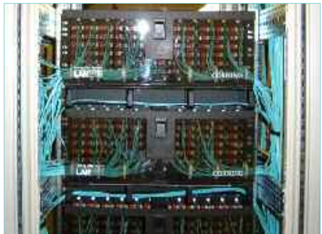
La baja densidad de puertos electrónicos y los cables voluminosos de cobre (arriba) resultan en trayectorias de cable congestionadas que dificultan su administración. La instalación llevada a cabo con fibra óptica es más densa, permitiendo mejor uso del espacio y es sencilla de administrar (abajo)
