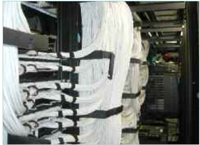
La baja densidad de puertos electrónicos y los cables voluminosos de cobre (arriba) resultan en trayectorias de cable congestionadas que dificultan su administración. La instalación llevada a cabo con fibra óptica es más densa, permitiendo mejor uso del espacio y es sencilla de administrar (abajo)
